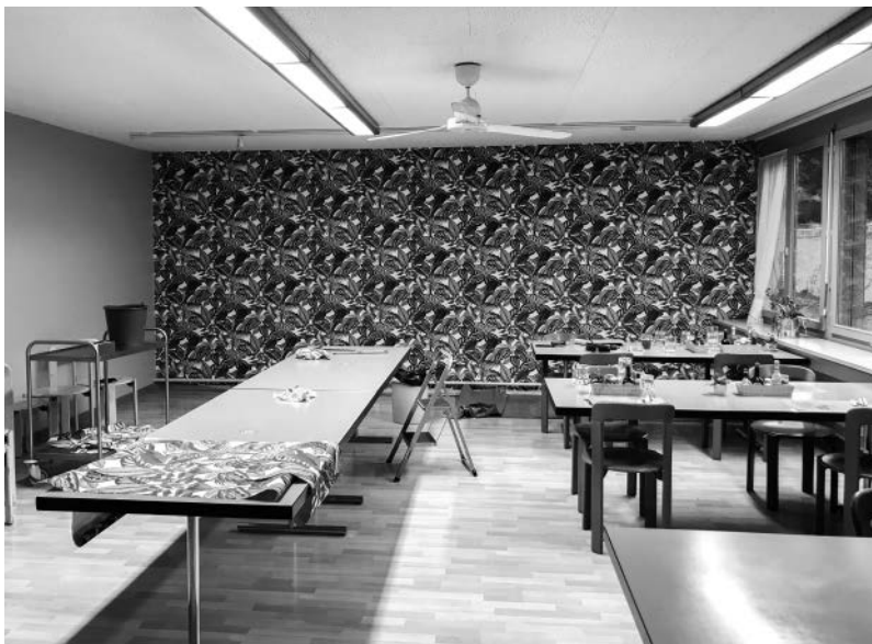
Die Renovationsarbeiten im Speisesaal der Gassenküche sind weit fortgeschritten.
